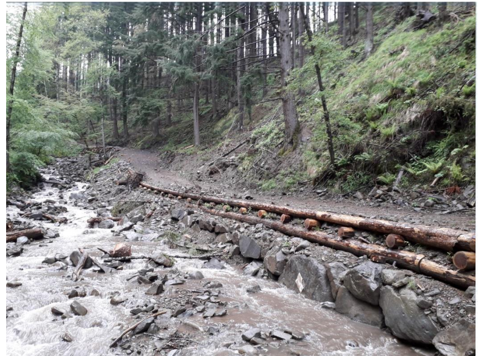
Foto 14 b – scogliera di protezione durante una piena (stato antecedente in Foto n. 7 e 8)
