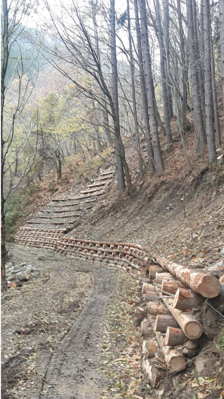
Foto 10 a – Palificata e grata vive con talee a fine lavori, prima dell'inserimento di piante radicate (stato antecedente in Foto n. 2 e 3)
