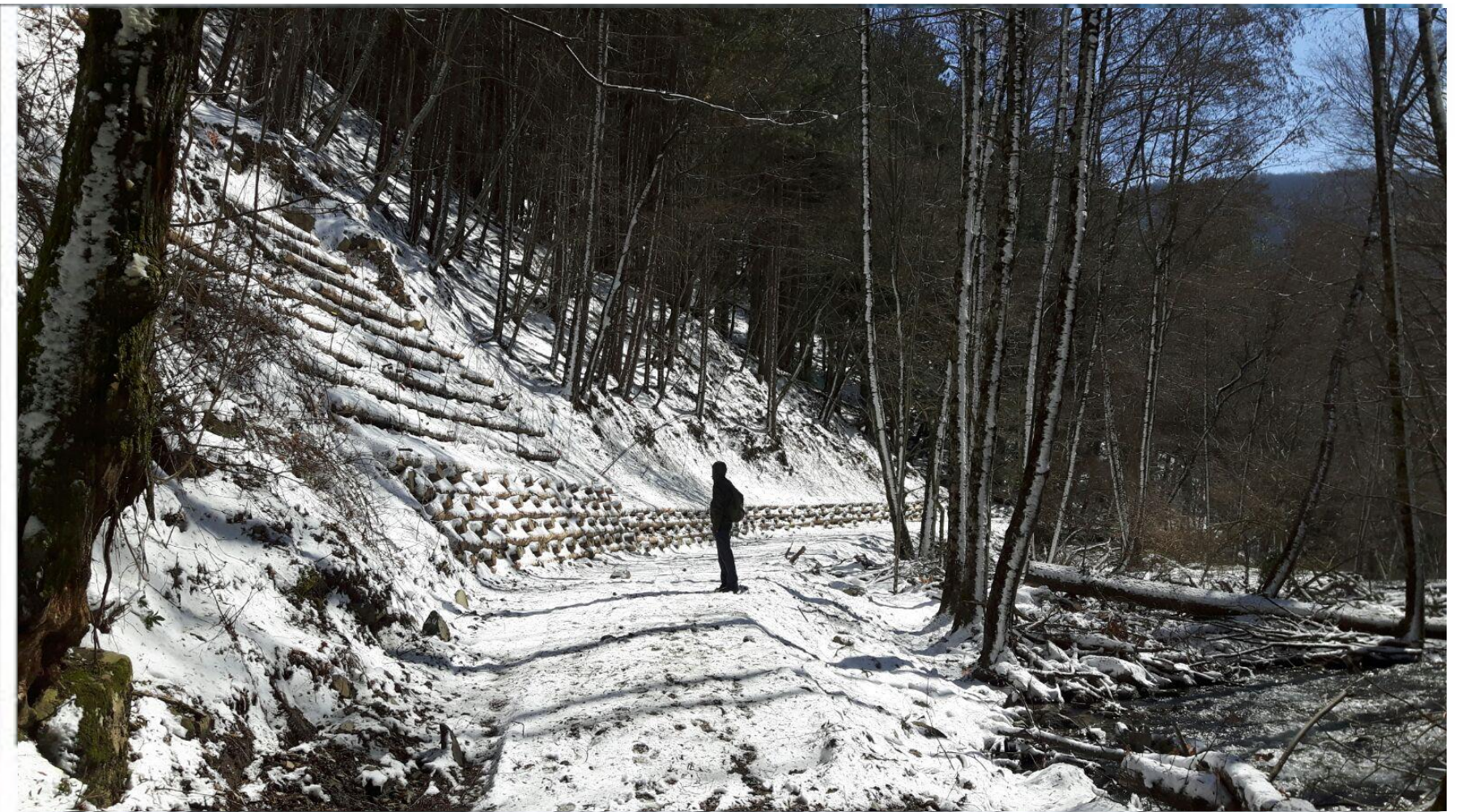
Foto 10 c –Palificate e grata viva durante una visita con Studenti dell'Università di Firenze
