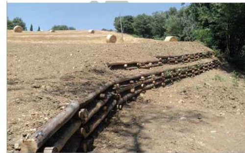
Foto 3 - Le strutture possono essere posizionate in maniera da assecondare la curvatura del versante sistemato.
